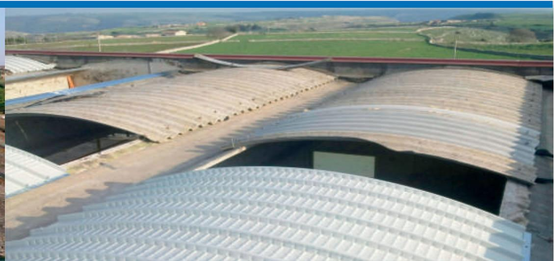
Sostituzione Lastre di eternit con pannello curvo coibentato (SR)
